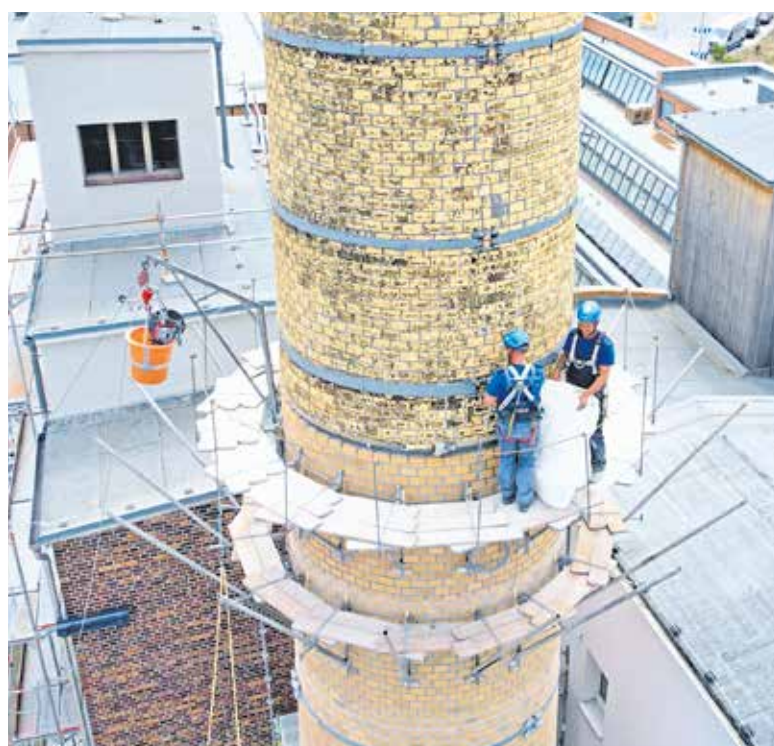
Zwei Jahre dauerte die Komplettanierung eines 40 Meter hohen und denkmalgeschützten Industrieschornsteins auf dem Gelände der Kulturweberei in Finsterwalde.
