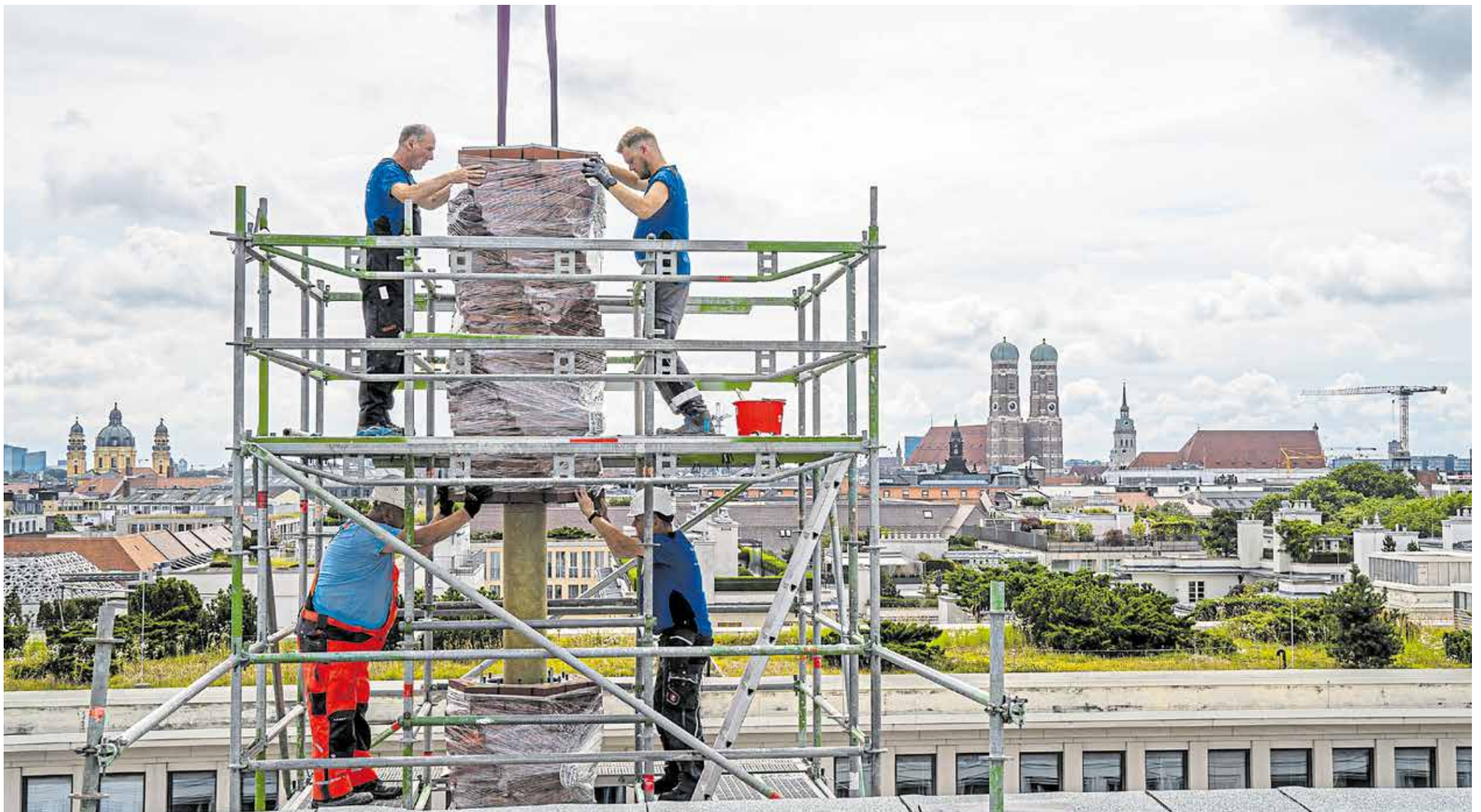
Hoch über München: Montage des Kunstschornsteins auf dem Dach des Berufsschulzentrums für das Bau- und Kunsthandwerk. Den Blick zur Frauenkirche konnten die Männer erst nach getaner Arbeit genießen.
