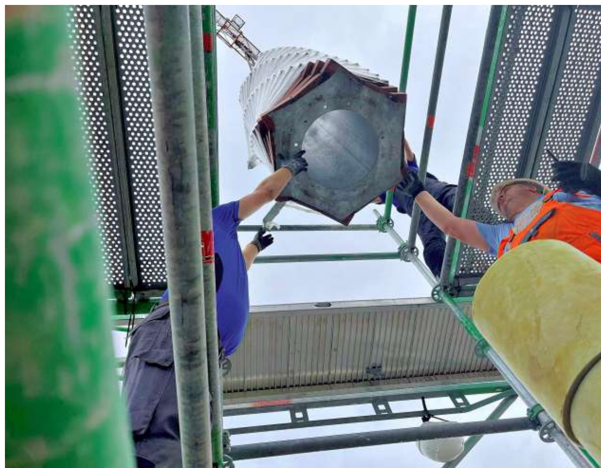
Hochpräzise Maßarbeit: Drei Beschäftigte des Balgstädter Spezialunternehmens weilen im Zuge der Endmontage auf der Baustelle an dem Münchener Berufsschulzentrum. FOTOS: ANDREAS LÖFFLER; GÜNTER SCHULZ GMBH & CO. KG(2)
